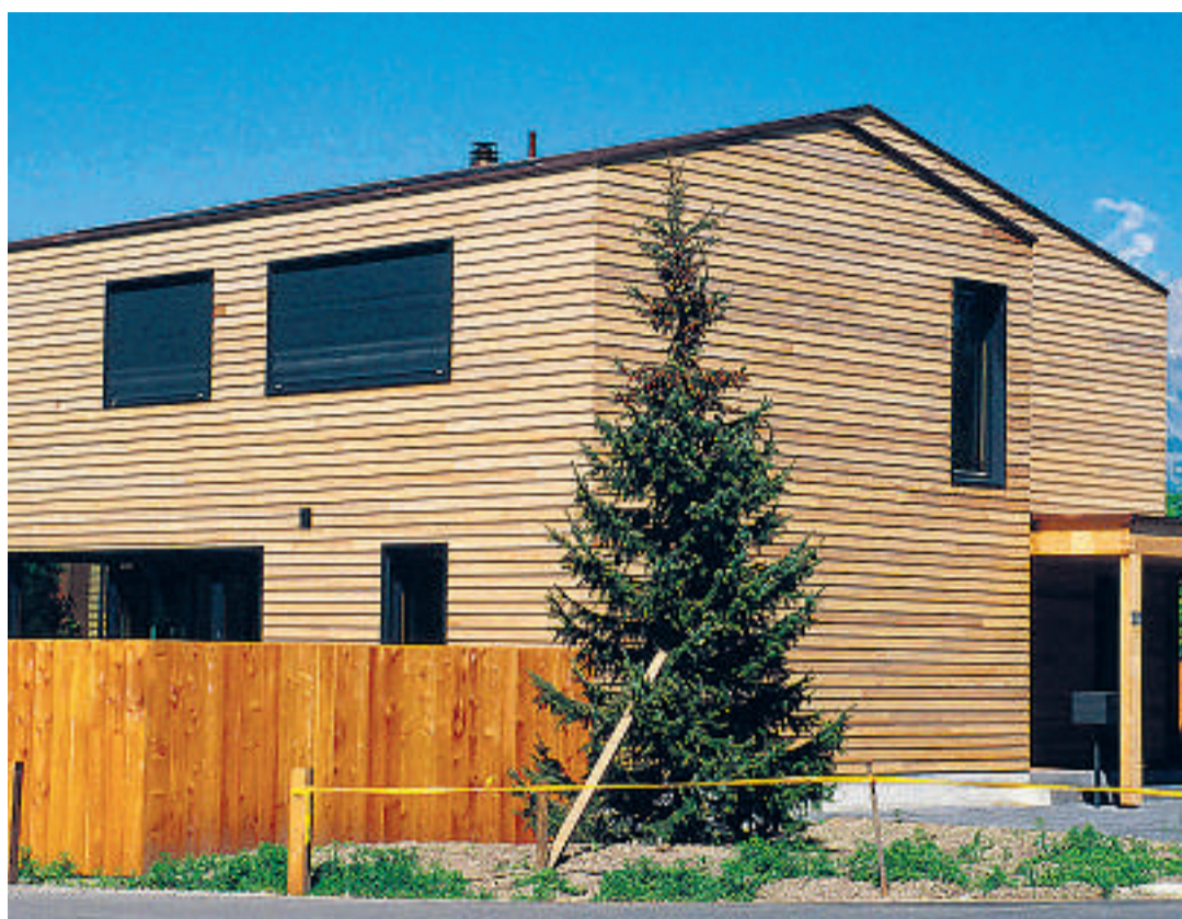
Eine ungeschützte Holzfassade hat eine kürzere Lebensdauer als beispielsweise ein verputztes Mauerwerk.
